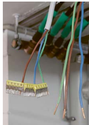
Bild 1: Fehlender Basisschutz
