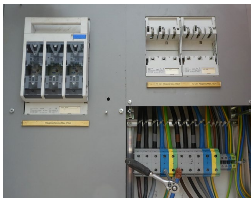
Figura 16: Quadro di cantiere (fonte ESTI)
