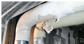
Mortier dans les canalisations
