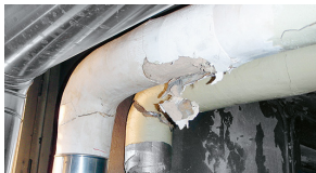
Mörtel bei Rohrleitung
