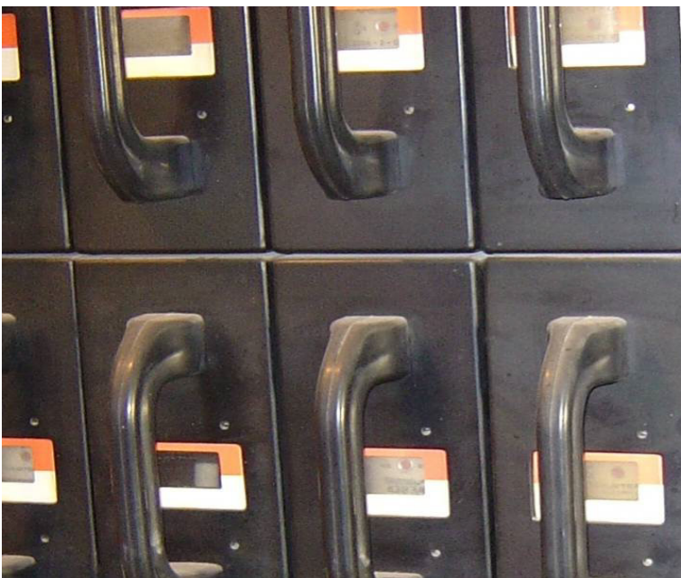
Bild 1: NHS-Sicherung unter Last
