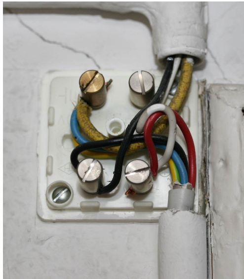
Bild 4: Abzweigdose (Schema III)
