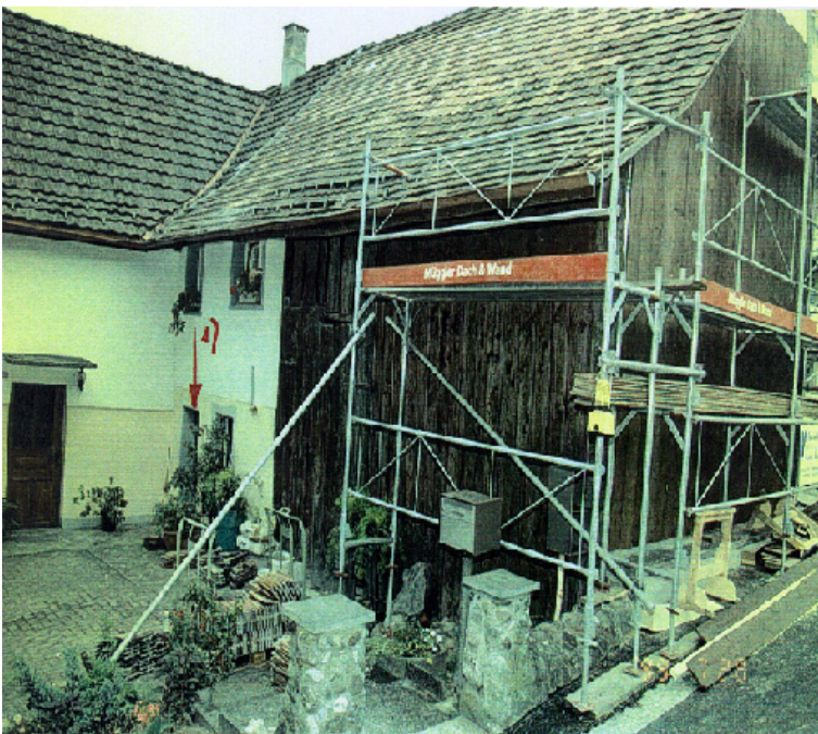
Bild 1: Hausfassade mit Stahlrohrgerüst
