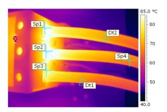
Das Wärmebild zeigt deutlich eine Schwachstelle in der Schaltgerätekombination an. Überhitzte Komponenten in elektrischen Anlagen werden mithilfe einer Wärmebildkamera entdeckt. Electrosuisse führt solche Messungen durch und analysiert für Sie den Zustand der Installation.
